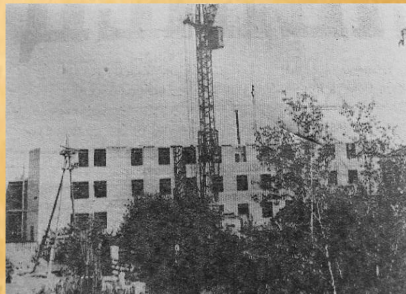
Строительство терапевтического корпуса Шербакульской ЦРБ, 1984 год
